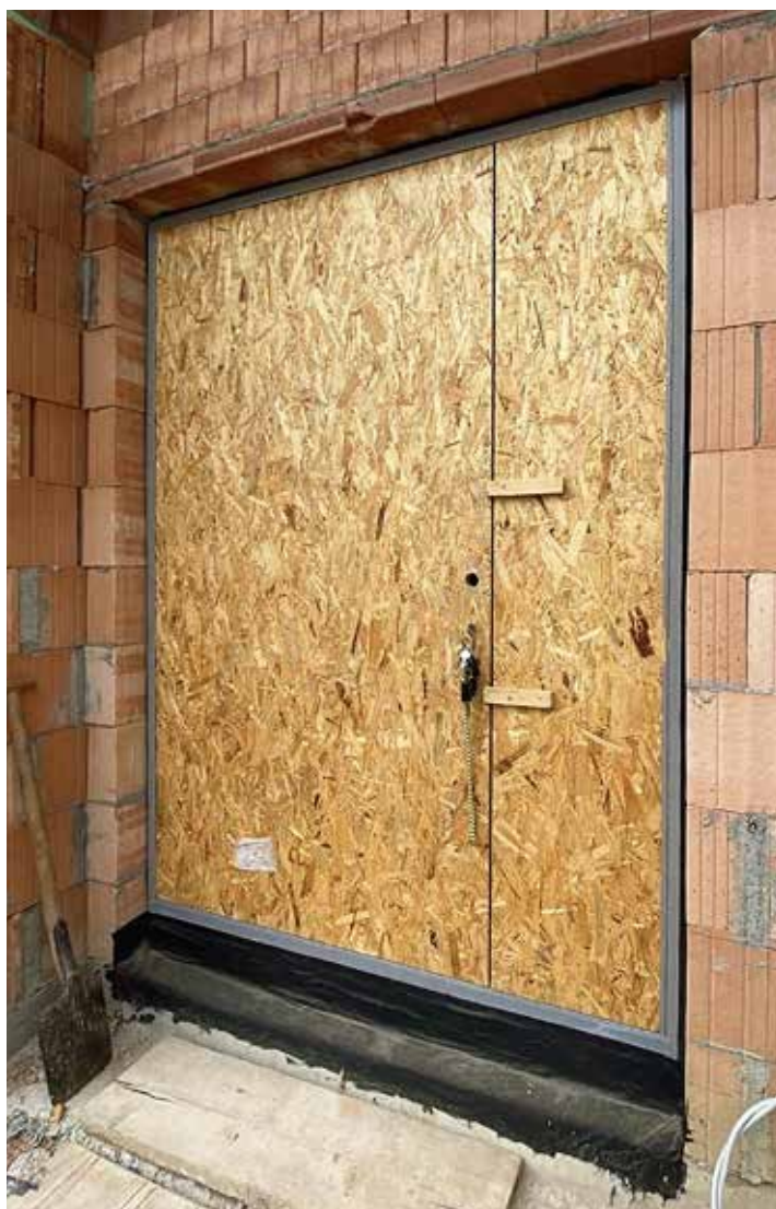
Una porta da cantiere con serratura semplice chiude provvisoriamente l'ingresso finché non viene montato il portoncino. Finstral fornisce su richiesta porte da cantiere premontate.
