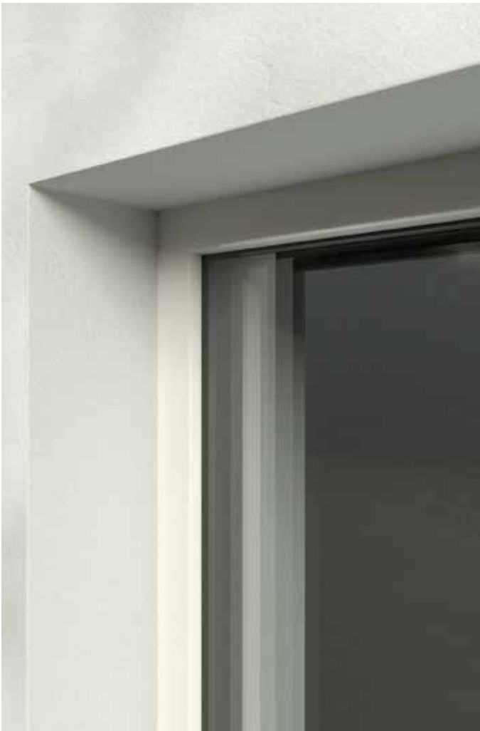
sichtbarer Einbau des Blendrahmens mit Montagezarge FIN-Fix
