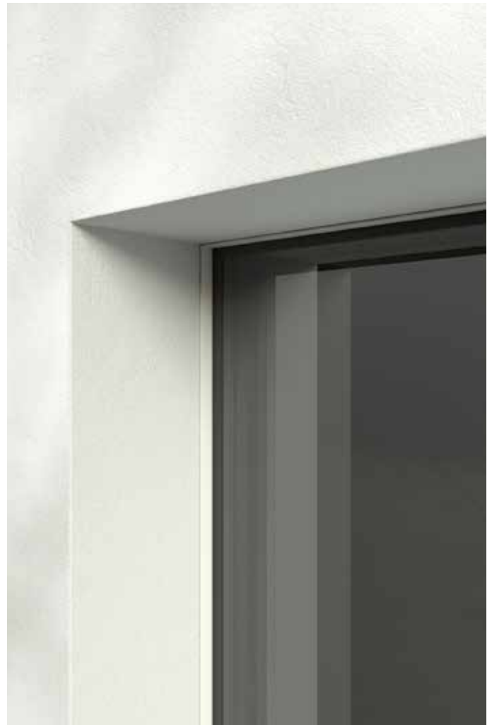
verdeckter Einbau des Blendrahmens
