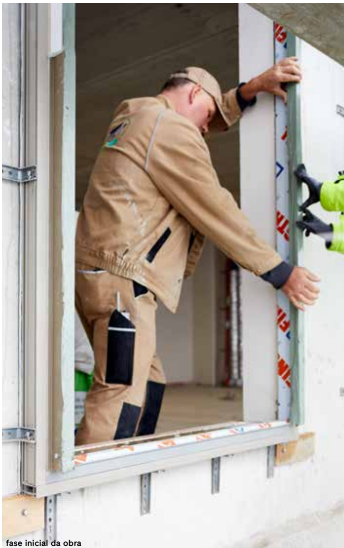
fase inicial da obra
