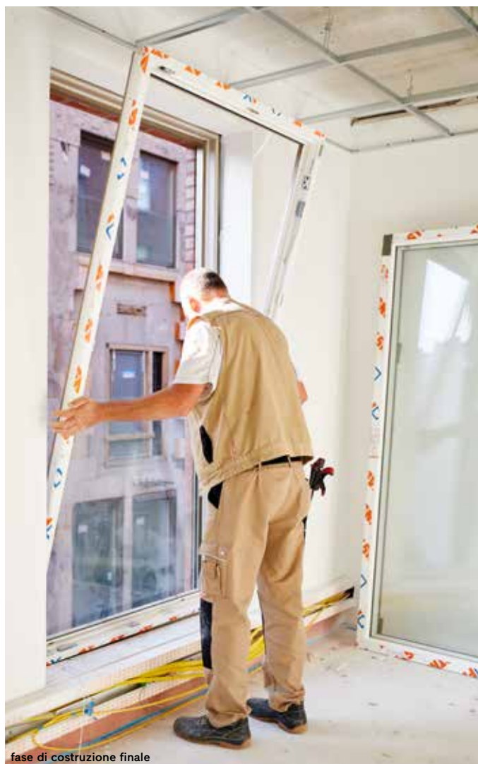
fase di costruzione finale
