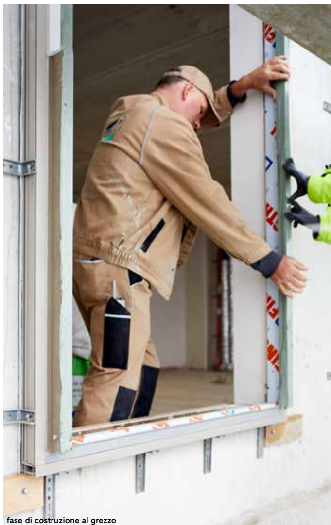
fase di costruzione al grezzo
